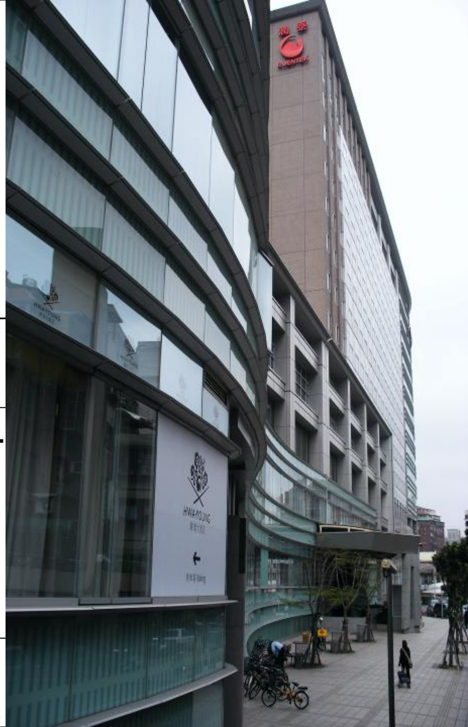
圖：潤泰中崙大樓
